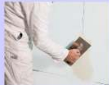
Plokščių siūlių užglaištymas su Remmers Schimmel-Sanierspachtel arba Schimmel-Sanierspachtel fein
