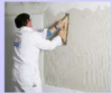
Plokštuma padengiama su Remmers Ansetzmörtel SLP naudojant dantytą mentelę
