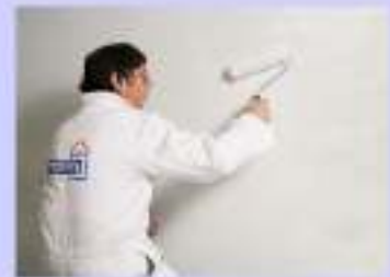
Paviršiaus dažymas su Remmers Schimmel-Sanierfarbe
